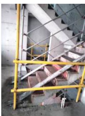
楼梯临边防护检查
