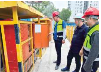
现场电箱检查
