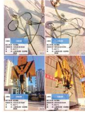
吊索具每日检查
