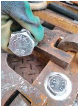
塔吊维保检查
