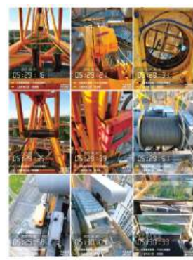
塔吊每日检查
