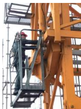
塔吊维保检查
